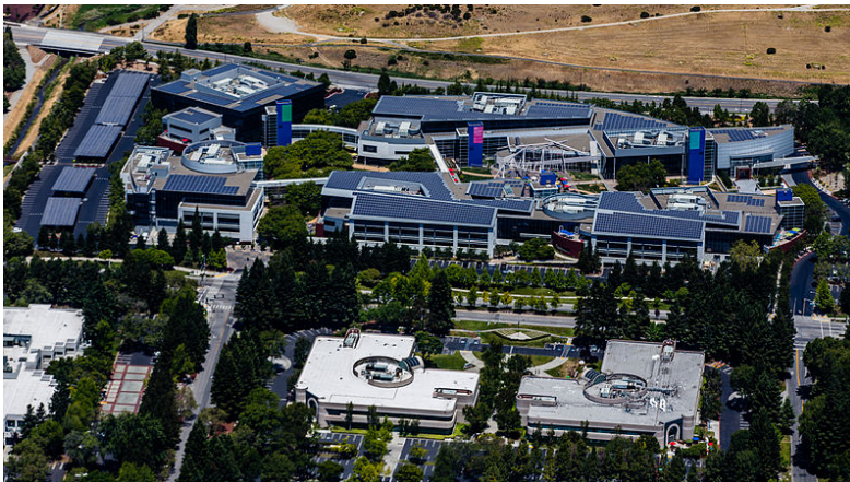
©Austin Mac Kinley – Wikipédia – Vue de Googleplex
